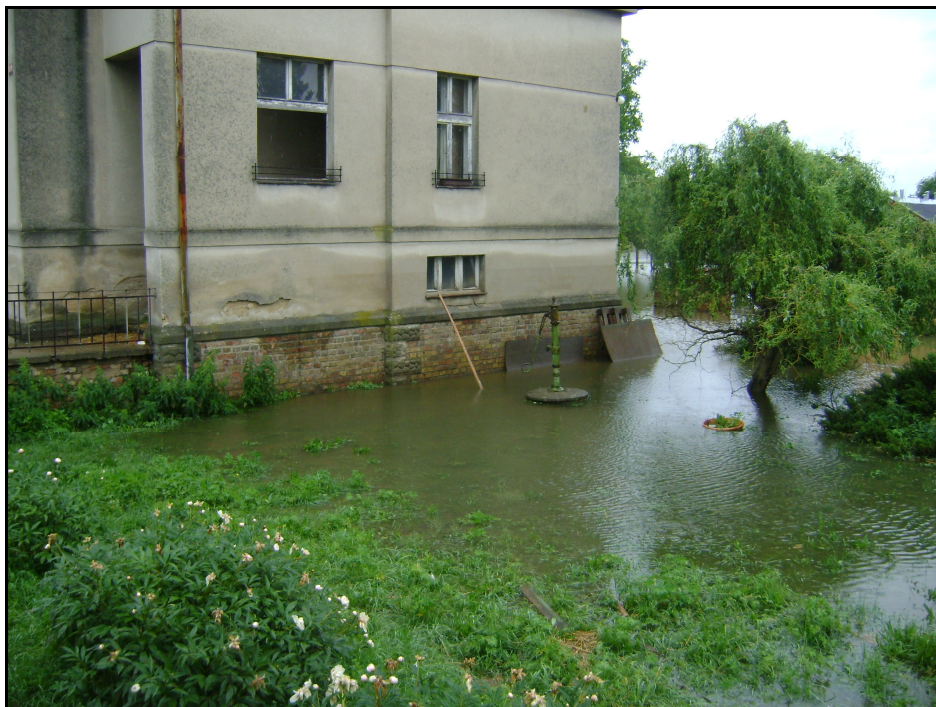
Obrázek 6: Zaplavené zahrady v ulici Pražská
