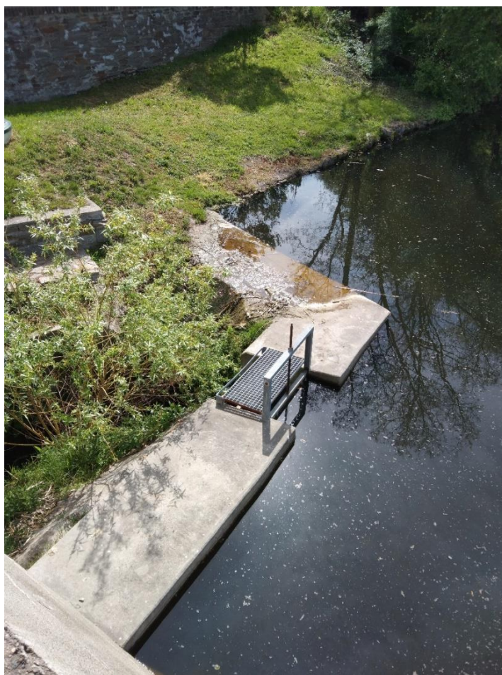
Bod č. 71 – Vegetace v bezpečnostním přelivu
