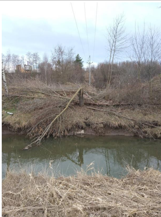
Bod č. 32 – vegetace zasahující do koryta
