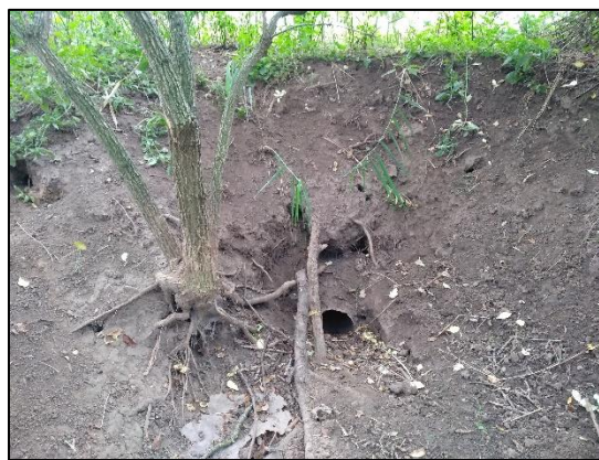
obr. 5 - Fotodokumentace vyústění melioračních zařízení
